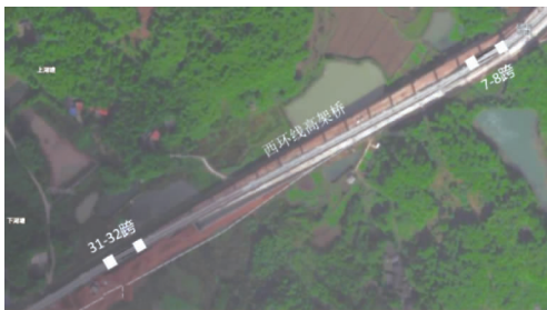
图 1 西环线高架桥
