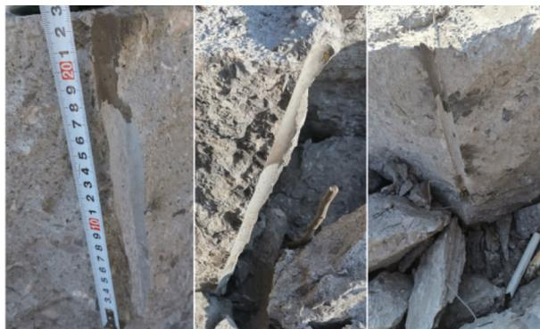
图7 无聚能穴不耦合装药结构爆破效果
