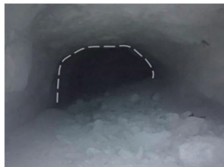
图5 优化后爆破效果
