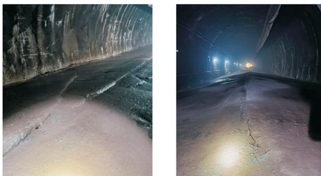
图2 横洞底板隆起变形
