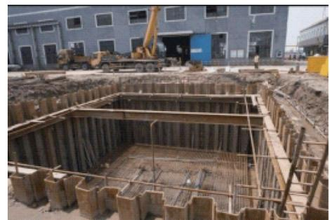
图2 基坑钢板桩施工
