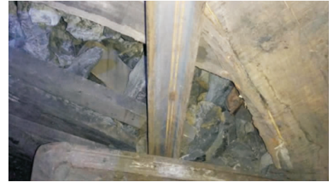
图3 -1212(21)工作面顶板情况
