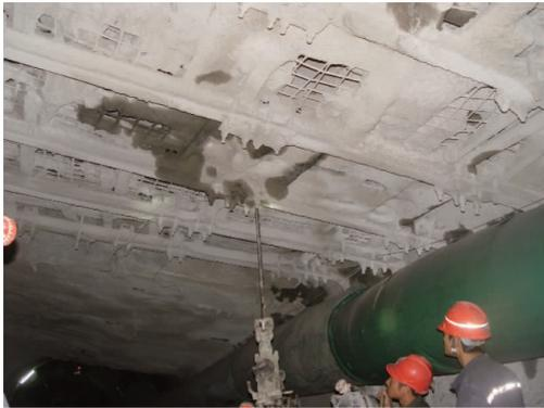
图11 支护后的巷道顶板
