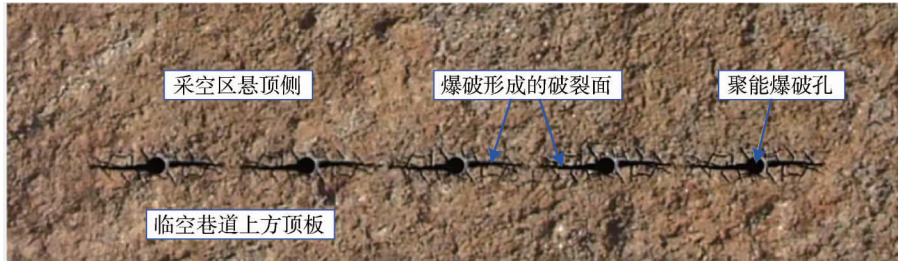
图6 聚能爆破形成的连续弱面
