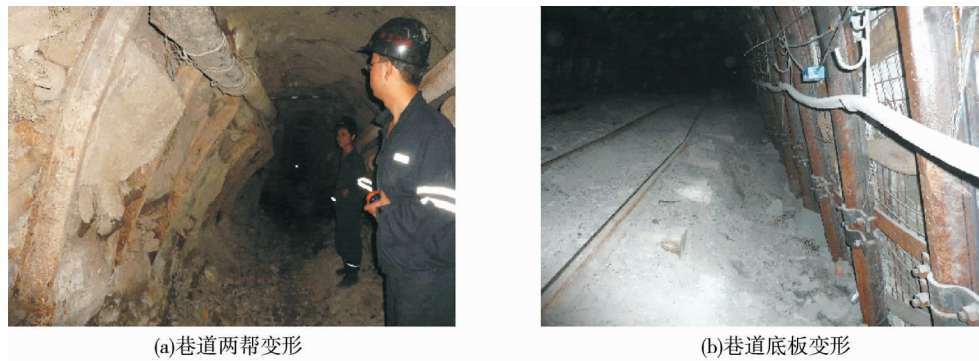
图 13 曲江公司大巷围岩监测照片
