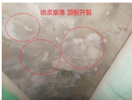
图3 顶板开裂
