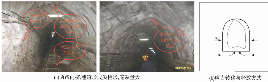
图7 水平应力大于垂直应力时的实际变形及应力释放方式(→表示应力释放方向)
