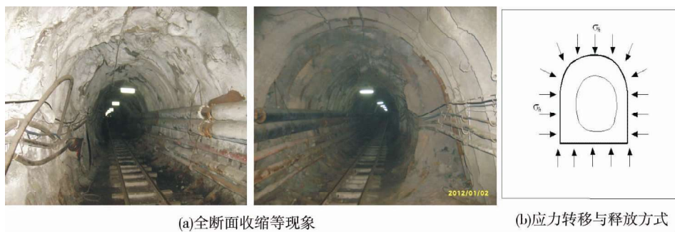
图9 垂直方向和水平方向均较高时的实际变形及应力释放方式(→表示应力释放方向)
