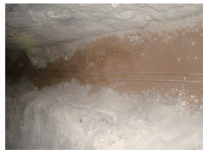
图 3 现场光纤铺设
