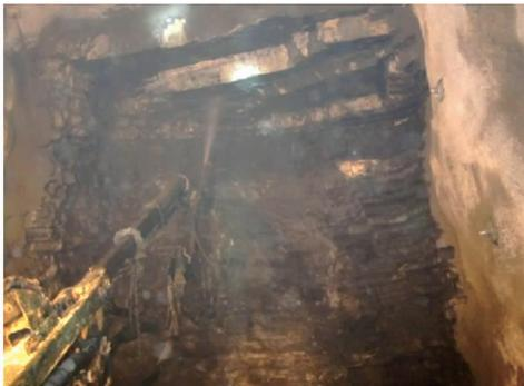
图4 高压水清洗工作面
