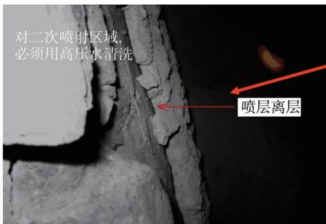
图5 高压水清洗二次喷射区
